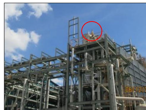
รูปที่ 3-43 Pressure Relief Valve
