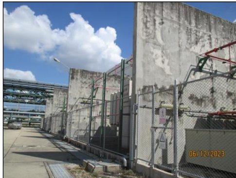
รูปที่ 3-21 พนักงานไฟระหว่างหม้อแปลงไฟฟ้าแต่ละชุด
