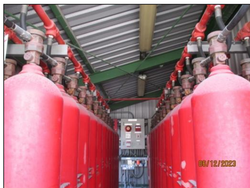
รูปที่ 3-40 Extinguisher Discharge System
