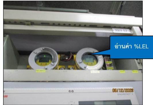
รูปที่ 3-45 Gas Detector Monitoring
