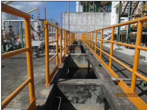
รูปที่ 3-8 บ่อพักน้ำ (Sump) ก่อนที่จะสูบน้ำฝน ไปยังระบบบำบัดน้ำเสีย
