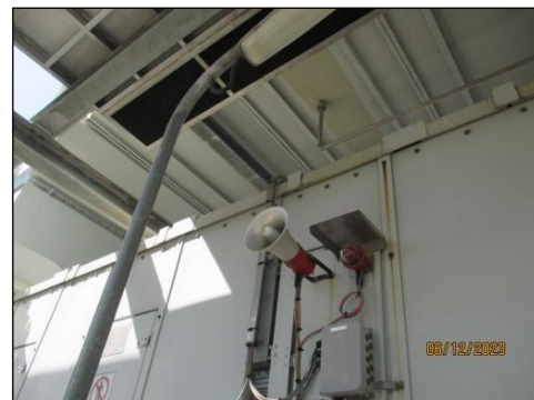
รูปที่ 3-26 Acoustic Alarm System
