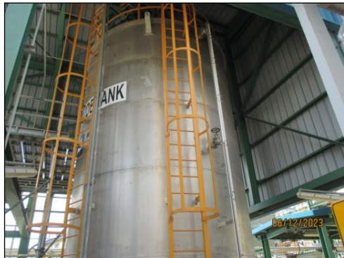
รูปที่ 3-30 ถังเก็บสารละลาย แอมโมเนียมไฮดรอกไซด์
