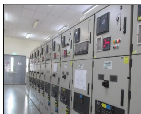
รูปที่ 3-19 ระบบ Remote Isolation
