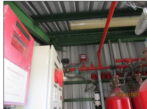
รูปที่ 3-39 Solenoid Valve CO 2
