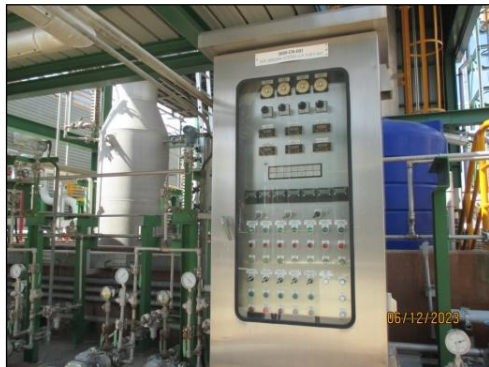
รูปที่ 3-32 การควบคุมสารละลาย แอมโมเนียมไฮดรอกไซด์ ด้วย DCS
